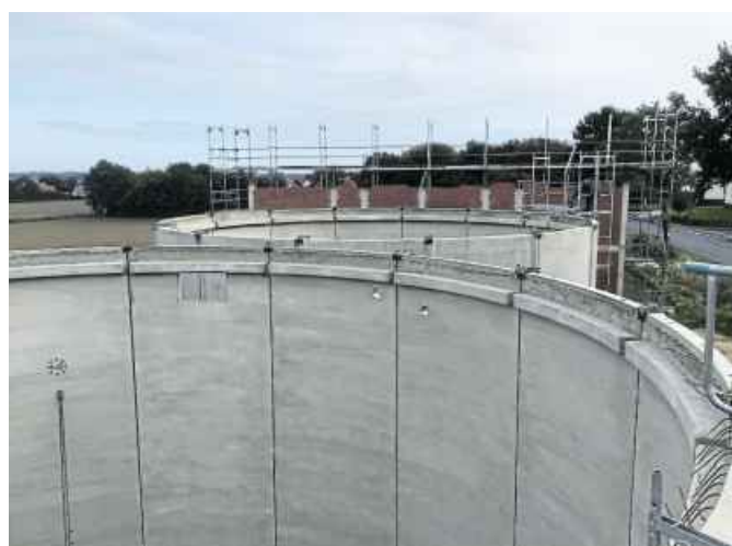
In Spannbetonbauweise wurden die beiden Behälter hergestellt.
