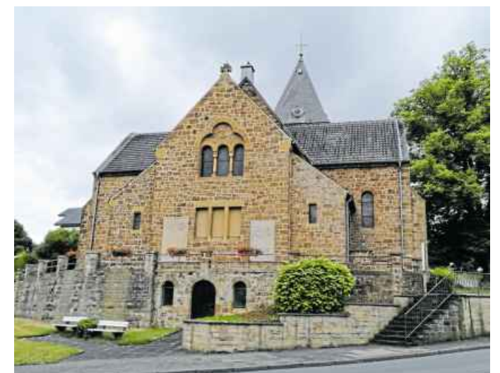
Das Heizen der Gebäude in den Gemeinden – hier die Kirche Bad Holzhausen – könnte viel teurer werden, wird befürchtet.
