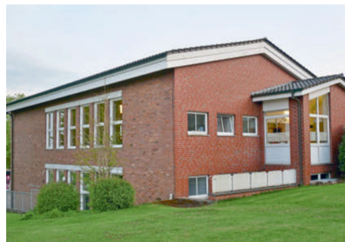
Im Jahre 1967 wurde das Gemeindehaus Oberbauerschaft eingeweiht, es folgten ein Ausbau und mehrere Sanierungen. Mittlerweile muss die Gemeinde die Räume vermieten, um die steigenden Kosten decken zu können.
