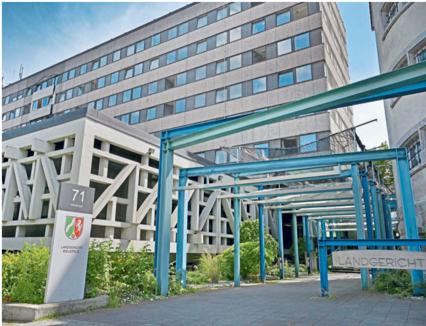
Vor dem Landgericht Bielefeld muss sich seit Dienstag ein 30-jähriger Hüllhorster wegen des Vorwurfs der Brandstiftung verantworten. Dass er auf der Anklagebank sitzt, hat er den Aufnahmen einer Überwachungskamera zu verdanken. Foto: Thomas F. Starke
