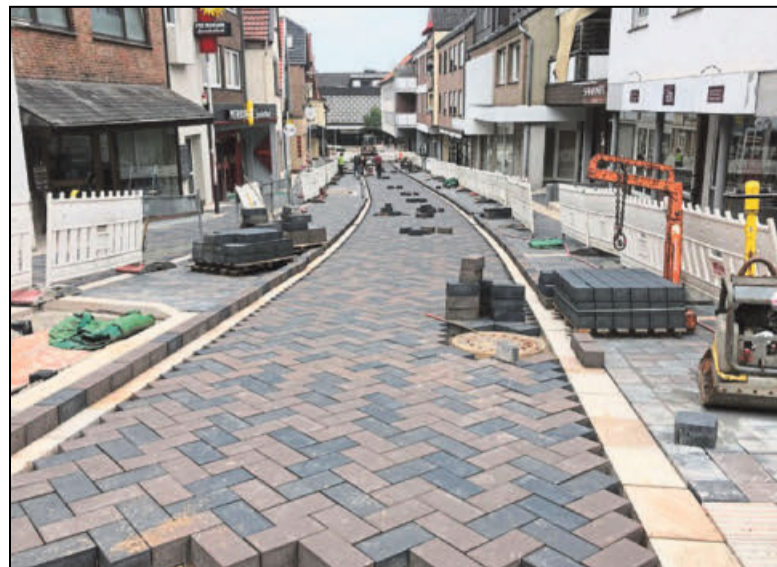
Die Umgestaltung der Tonstraße in Lübbecke ist nahezu abgeschlossen. Bald ist die Durchfahrt wieder möglich.
