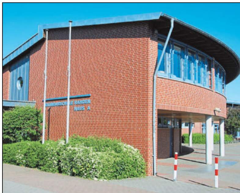
Die Sekundarschule Rahden, hier ein Teil des Objektes, soll durch einen Neubau erweitert werden. Foto: Dieter Wehbrink
