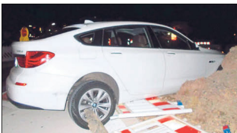
In die Kreisel-Baustelle gekracht: Der BMW hat die Warnbaken überrollt. Wer am Steuer gesessen hat, ist unklar.
