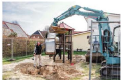
Neue Baummaßnahme: Rutsche und Spielturn werden abgebaut.
